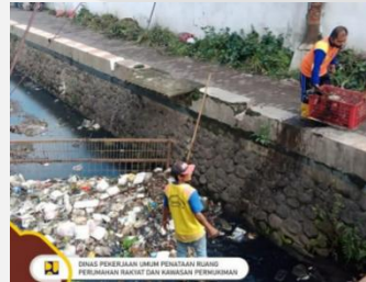
Gambar 18. Infrastruktur Penangkap Sampah di Saluran Drainase
